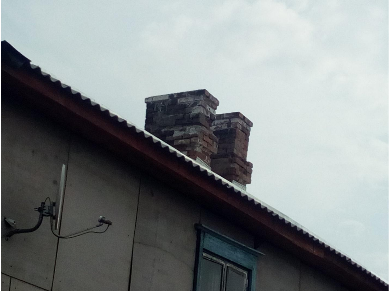
с. Сухобузимское ул. Комсомольская д. 58 ремонт крыши
