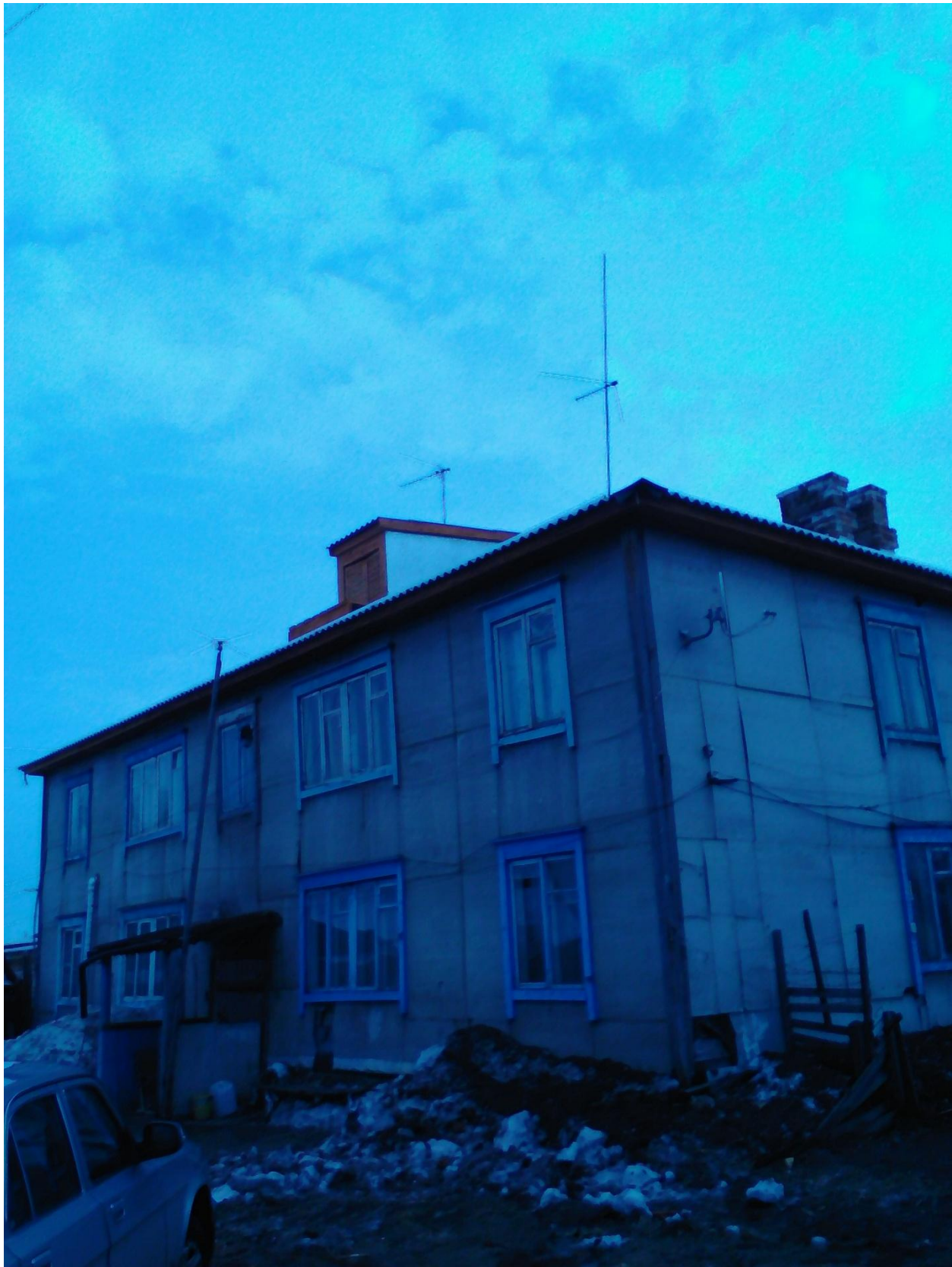
с.Сухобузимское ул.Комсомольская д.58 ремонт крыши
