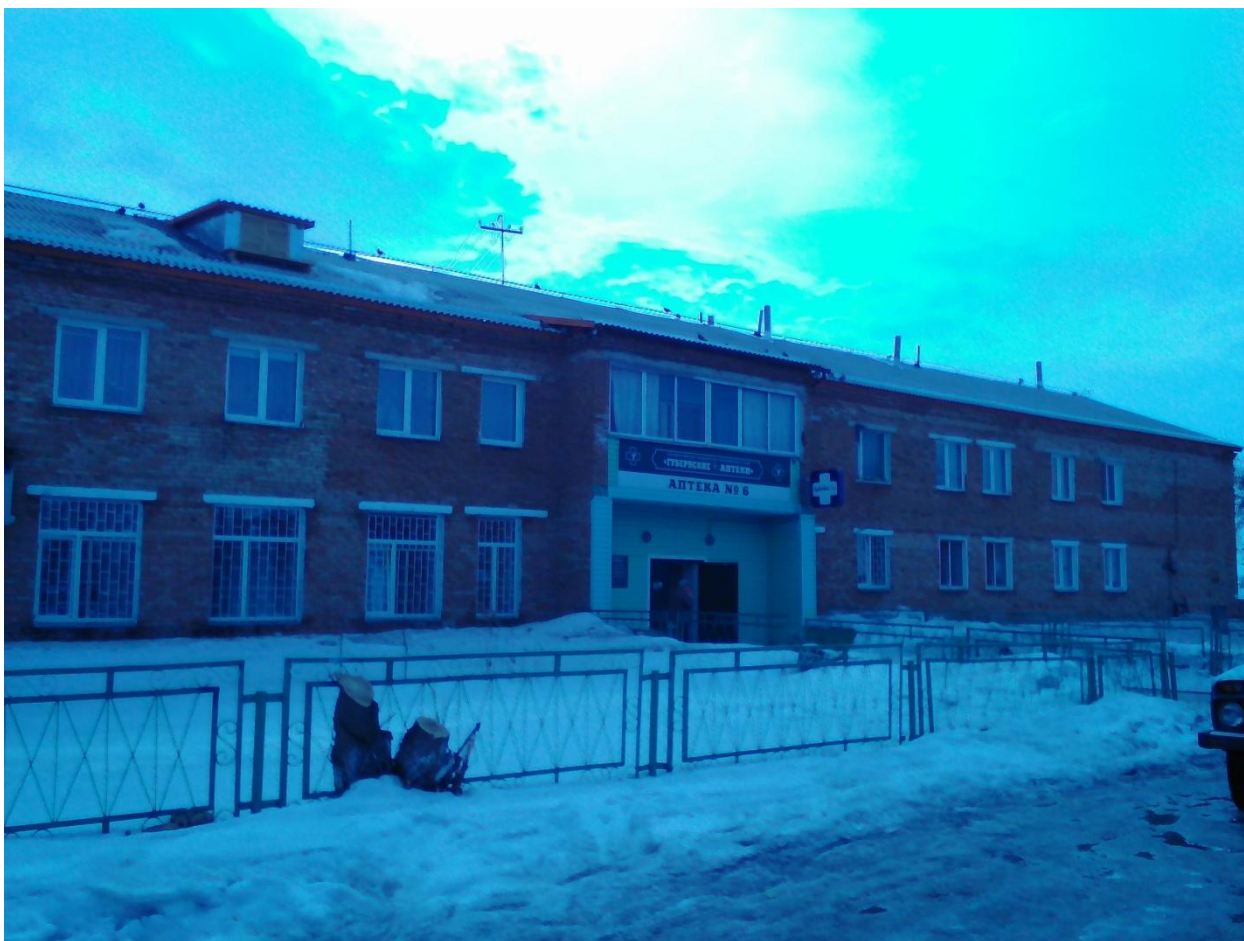
с.Сухобузимское, ул.Ленина д.67 ремонт крыши
