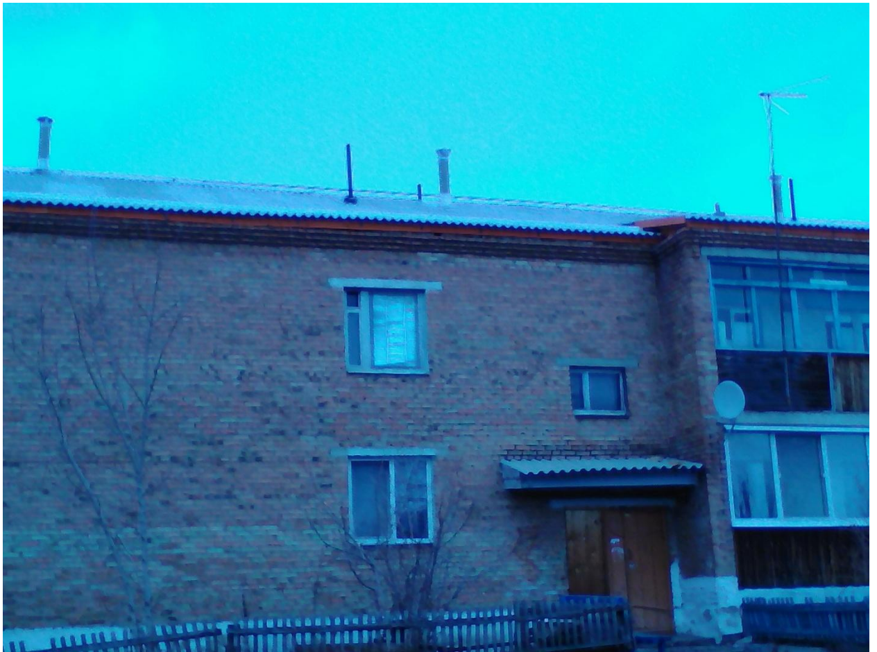
с.Сухобузимское ул.Ленина д.67 ремонт крыши
